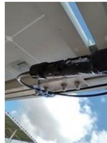
Por favor, preste atenção que o método de desbloqueio dos conectores é diferente de acordo com as leis e regulamentos locais. Durante a construção da usina, o conector não deve ser exposto ao ambiente externo em estado desconectado por muito tempo, de modo a evitar a poeira no ambiente do conector, resultando na perda da confiabilidade da conexão do conector.
